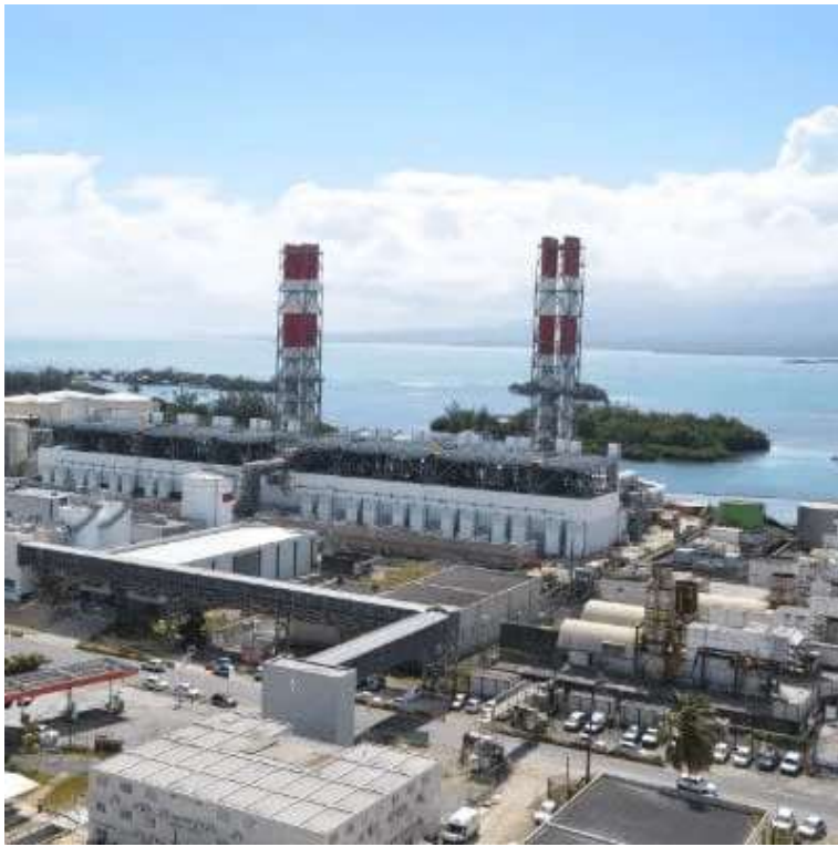
Centrale moteurs fonctionnant au fioul lourd de Jarry (Guadeloupe) 212 MW, en cours de fermeture.
